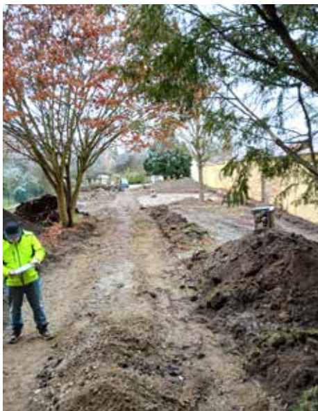
přípravné stavební práce na revitalizaci borůvkové zahrady
