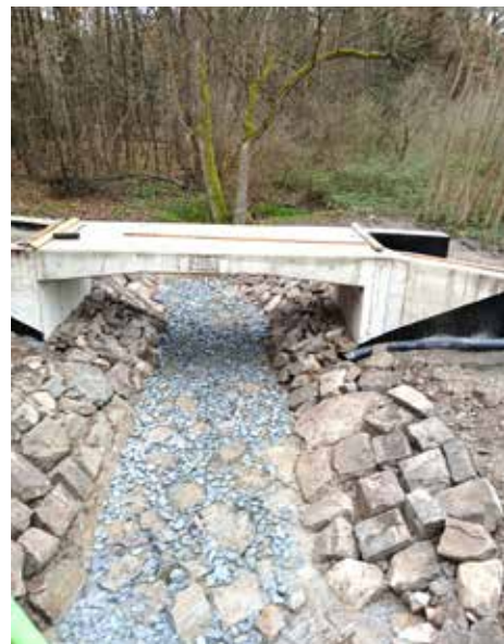
výstavba nové lávky přes Radostický potok
