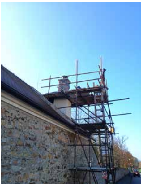
oprava komínu na tzv. „skleníku“
