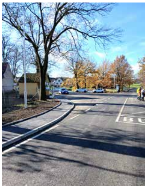
dokončená rekonstrukce průtahu silnice III. třídy v místní části Třebeč
