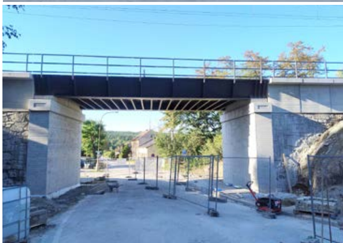
Během letošního léta prošel borovanský viadukt rozsáhlou rekonstrukcí. Původní most, který už dosluhoval po více než půldruhé století, nahradila moderní stavba připravená sloužit dalším generacím.
