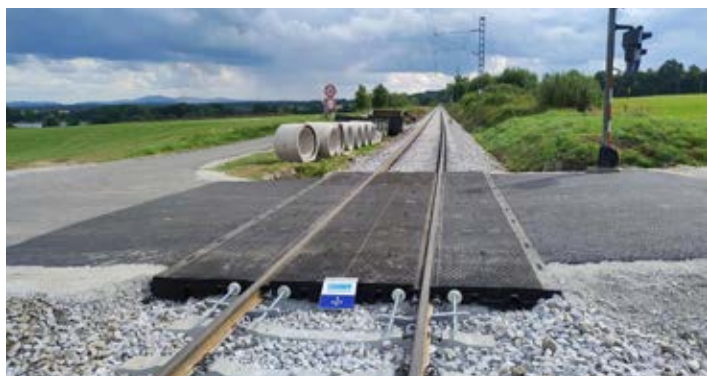
Během letních prázdnin se podařilo opravit hned dva železniční přejezdy – ve městě u křižení ulic Krčínova a Ke Střelnici (P1107) a u zastávky Hluboká u Borovan (P1106). Opravy probíhaly v návaznosti na rekonstrukci viaduktu a dnes už jsou oba přejezdy znovu plně průjezdné.
