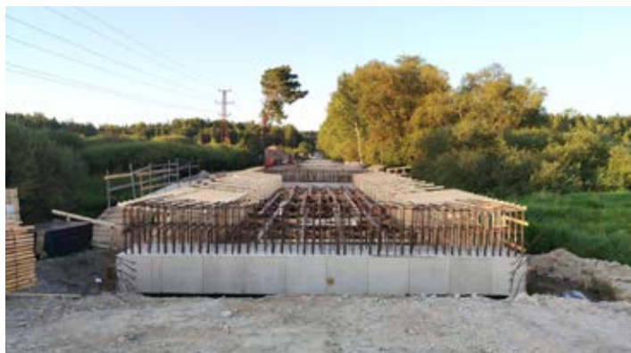
Fotografie zachycuje práce probíhající při rekonstrukci mostů přes řeku Stropnici u Brouskova mlýna poblíž vlakového nádraží Jílovice. Rekonstrukce probíhá dle plánu a žádá si uzavření silnice III/15428 ve zmíněném úseku do 18. listopadu 2025.
