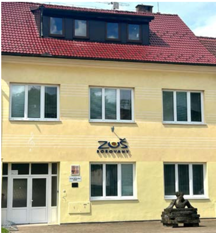
Budova ZUŠ na Žižkově náměstí 20 prošla kompletní výměnou střešní krytiny. Nová betonová taška nahradila původní poškozený asfaltový šindel. Součástí oprav bylo i oplechování, výměna oken ve vikýři a nový nátěr římsy. Práce trvaly necelé dva týdny a realizovala je firma Střecha Profi ve spolupráci s místními řemeslníky.
