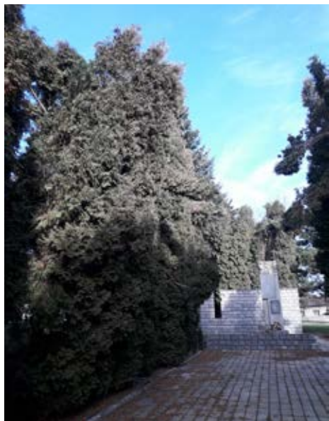
stav před opravou
